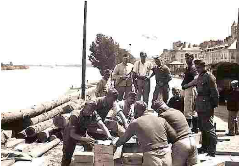
Reparaturarbeiten an der Cessart-Brücke 1940
